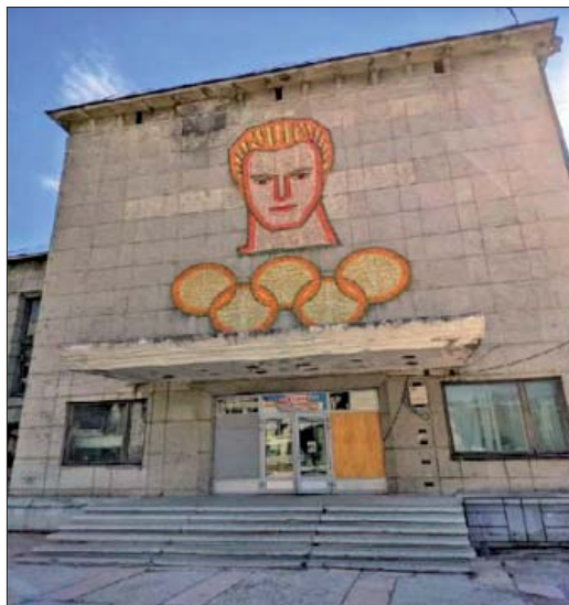
Рис. 7. Панно на здании Дворца культуры судостроителей, г. Комсомольск-на-Амуре, ул. Аллея Труда, 22 1
