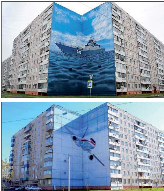
Рис. 10. Панно на зданиях жилых домов, г. Комсомольск-на-Амуре, ул. Бульвар Юности, 16 и ул. Гагарина, 2/2
