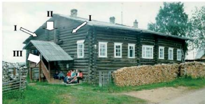
Рисунок 2. Традиционный коми дом (с. Усть-Кулом) [2]. Конструктивные особенности: I – общий сруб состоит из набора срубов, соединенных перерубами; II – конструктивный элемент «заулок» (между срубными модулями); III – крытое крыльцо. Фото В. Б. Кошаева
