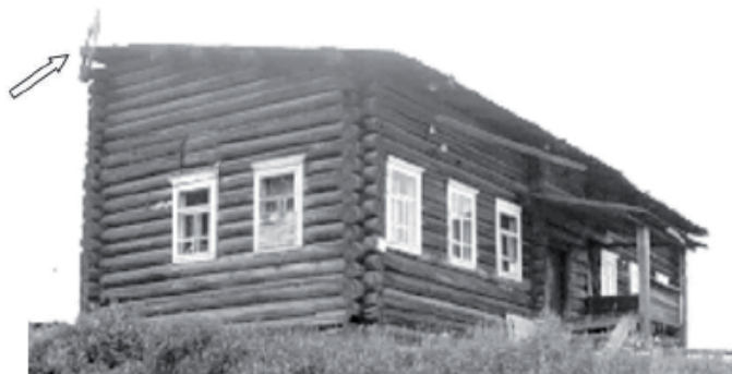
Рисунок 1. Половина дома в качестве самостоятельной постройки [2] (с. Усть-Кулом). Конструктивный элемент – чиби. Фото В. Б. Кошаева
